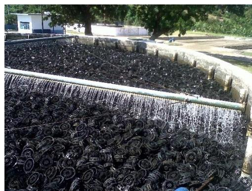
Con estos sistemas se persigue aumentar la capacidad de tratamiento de los reactores convencionales, incrementando la cantidad de macroorganismo presentes en el sistema, sin el correspondiente aumento del volumen de los reactores. Esto se consigue empleando soportes con una elevada superficie específica sobre los que se desarrolla la biomasa en forma de biopelícula.
